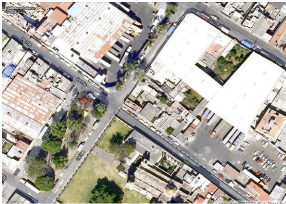
Fotografía aérea de templo de Santa Anita y Plazuela, se puede apreciar las naves industriales de la industria La Italiana. Foto:Autor
