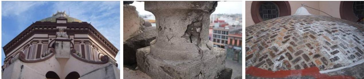
Figura 1. Deterioros en botareles, remates y cúpulas.
